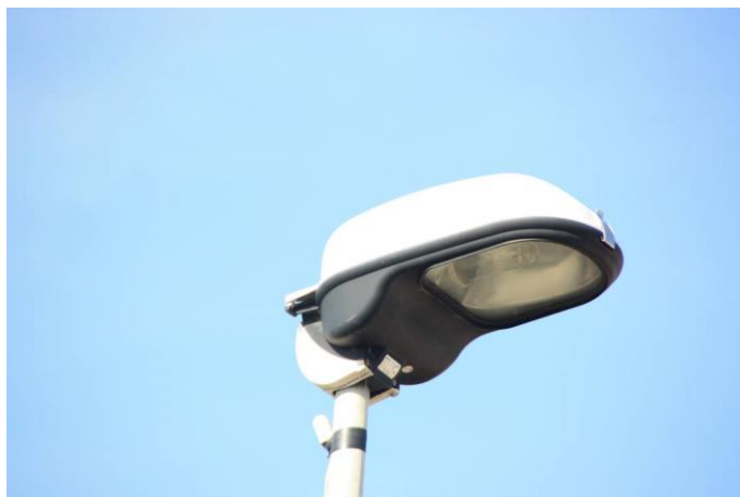
Armature stradali con ottica cut-off
