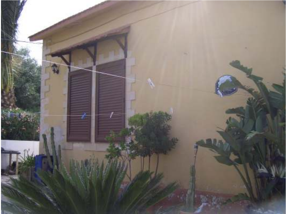
PARTICOLARE DEL PROSPETTO PRINCIPALE
