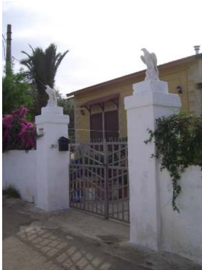
L'EDIFICIO COME SI PRESENTA ALL'AFFACCIO SULLA STRADA
