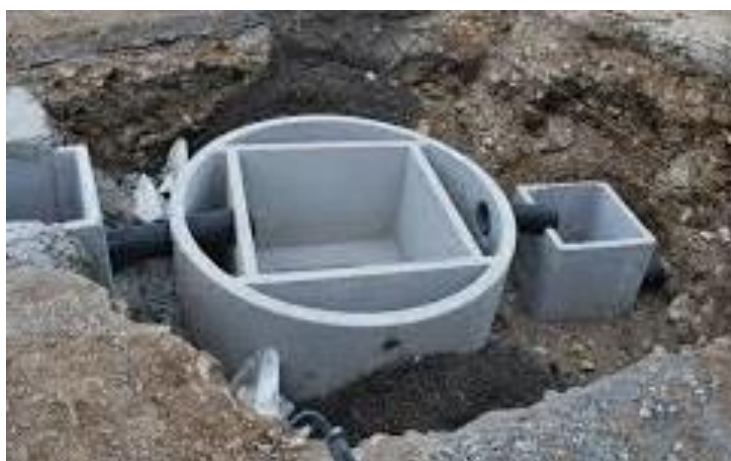
(Esempio di fossa imhoff in calcestruzzo precompresso)
